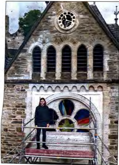
Bernhard Adams beim Einbau Fotos: Martin Lässig
